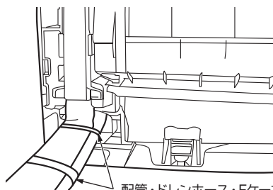
配管・ドレンホース・Fケーブルをまとめ、ビニールテープで止めます。
