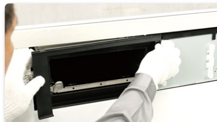
5 IHを固定し、各パーツを取り付け
